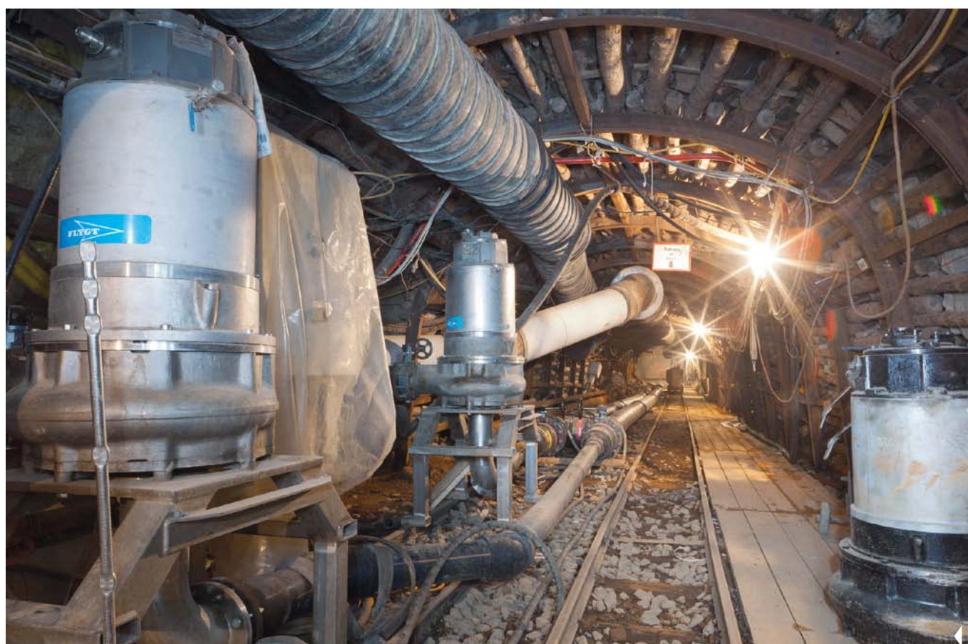
Vorbereitung der Flutung der Grube Königstein (Foto: Wismut GmbH)
