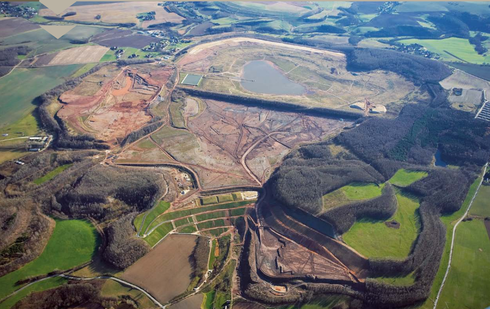
Luftbild der industriellen Absetzanlage Culmitzsch (Foto: Wismut GmbH)
