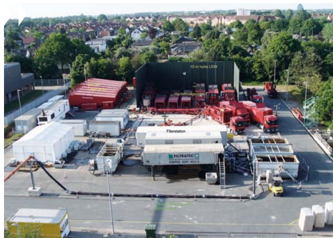
Der GeneSys-Bohrplatz während der Fracoperation im Mai 2011
