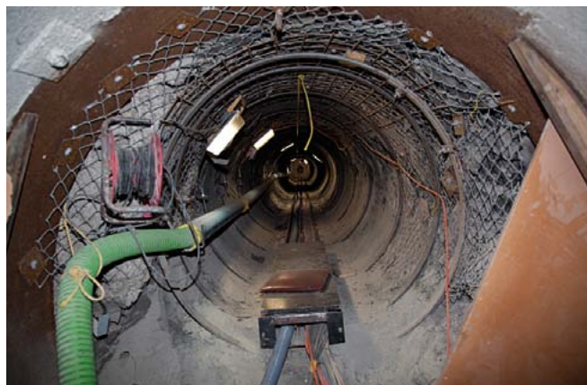
Zugang zum Tunnelsegment, in welchem im Massstab 1:2,5 ein Erhitzer-Experiment durchgeführt wird.
