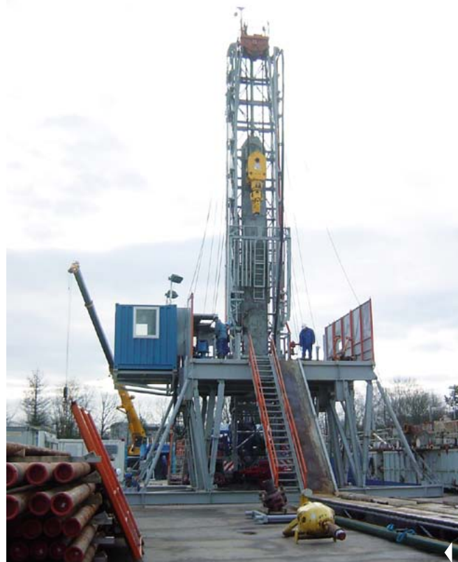
Einbau einer zusätzlichen Verrohrung in die GeneSys-Bohrung im Februar 2011
