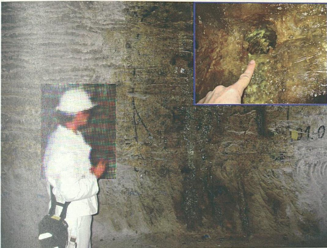
Abb. 1: Verschmierte KW-Austrittsstelle am Stoß. Im Bohrloch mit Tropfen- und Saumbildung durch nicht-flüchtige KW längs bevorzugter Wegsamkeiten in der Auflockerungszone des Hauptsalzes (Querschlag 1 West)
