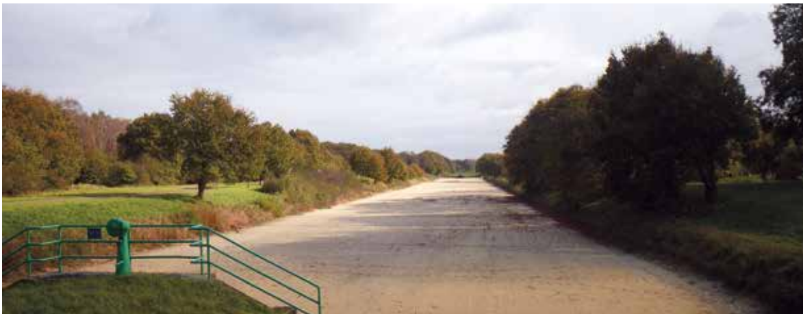
Sogenannter Langsandsandfilter, bei dem Oberflächenwasser durch Halterner Quarzsande in den Untergrund infiltriert und später durch Brunnen als (schon vorgereinigtes) Rohwasser wieder gefördert wird, Foto: DVGW e.V. (mit frdl. Genehmigung).
