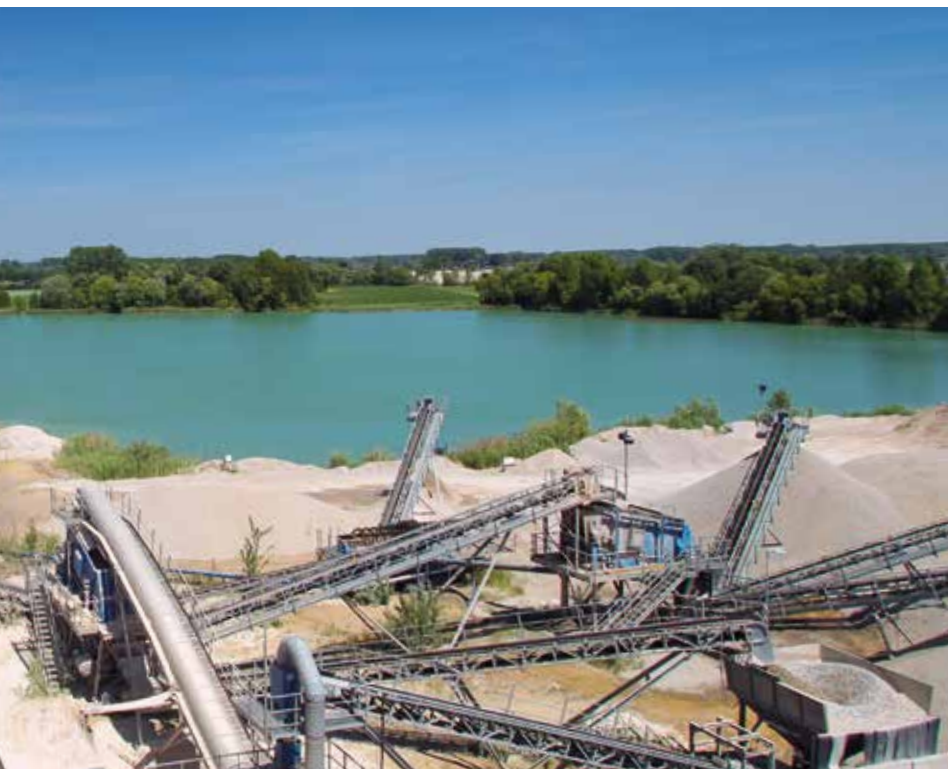
Durch Fraktionierung werden die Rohkiessande in verschiedene Korngrößen getrennt, Foto: Holcim (Süddeutschland) GmbH (mit frdl. Genehmigung).
