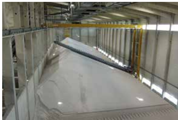
20.000 Tonnenlager für eisenarme Quarzsande der Schlingmeier Quarzsand GmbH & Co. KG in Uhry, Foto: BGR.
