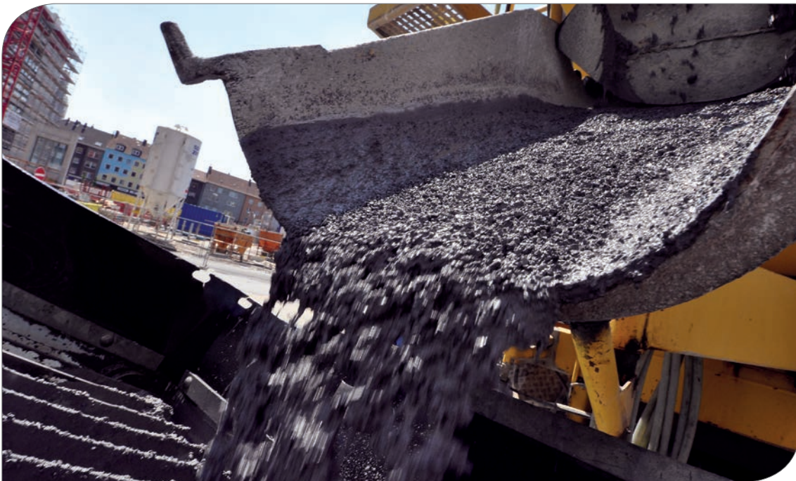
Abb. 2: Die in Deutschland häufigste Transportbetonsorte C25/30 enthält neben 290 kg Zement, 176 l Wasser und 60 kg Steinkohlenflugasche pro Kubikmeter rund 1.820 kg Gesteinszuschläge in Form von 364 kg Sand und 1.456 kg Kies oder Splitt, Foto & Copyright: Holger Kotzan/InformationsZentrum Beton GmbH.
