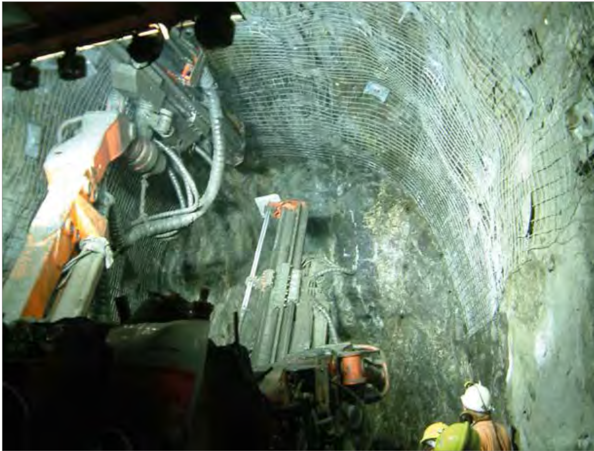
Abbildung 7: Sicherungsarbeiten vor weiterer Streckenauffahrung in der Renison Bell Zinnmine, Tasmanien. Foto: BGR.
