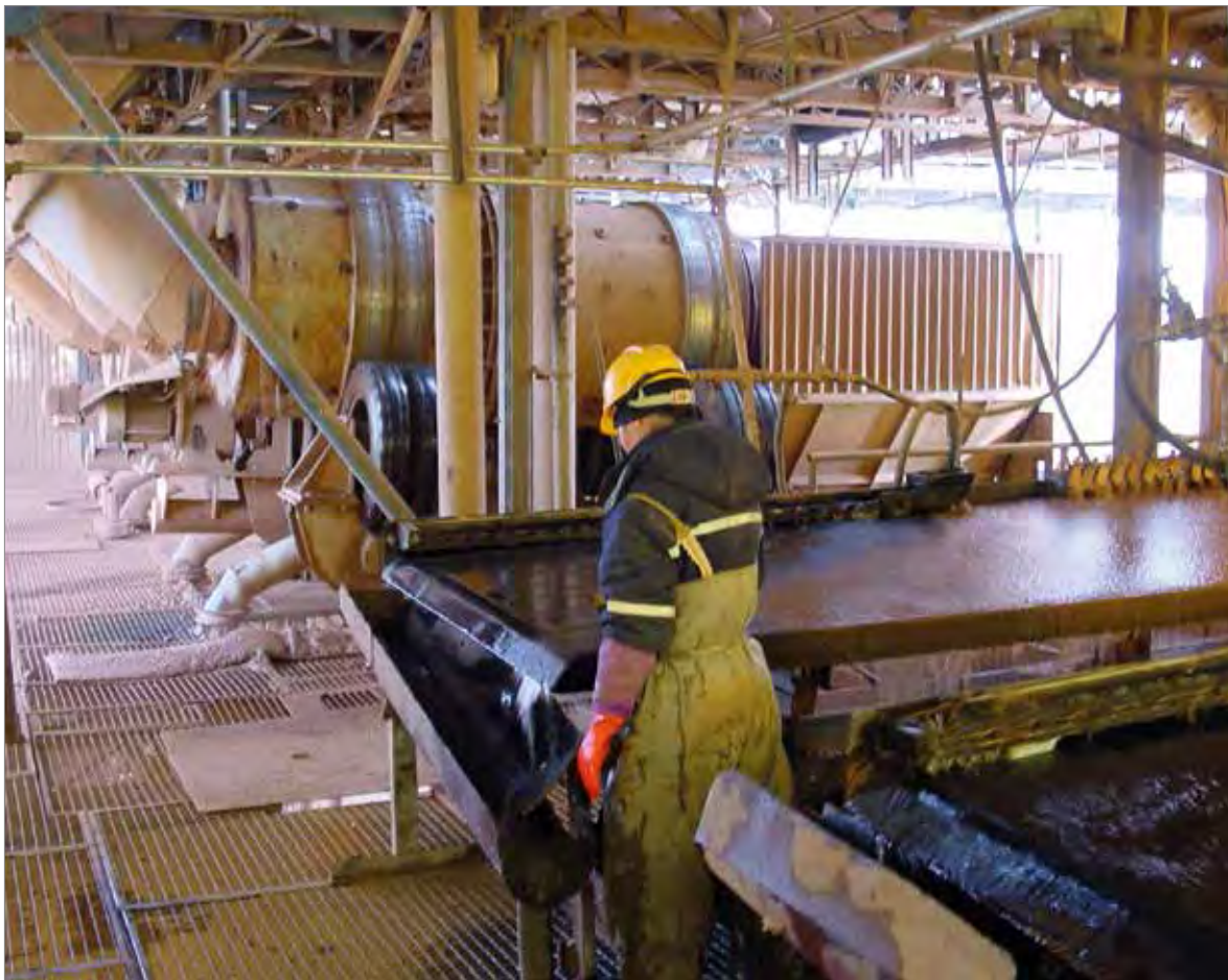
Abbildung 50: Blick in die Aufbereitungsanlage der National Mongolian Company im Sommer 2008. Foto: BGR.
