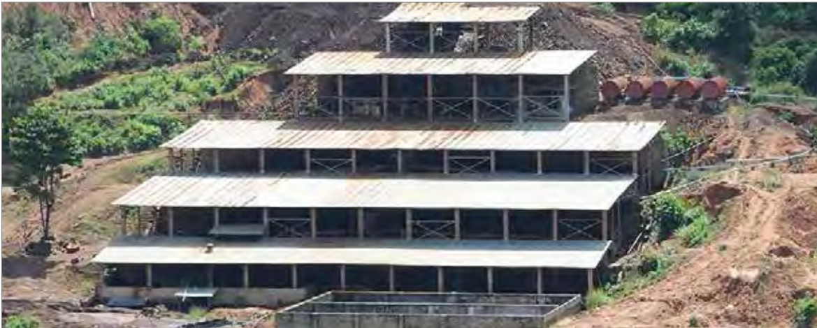
Abbildung 53: Aufbereitungsanlage für Zinn-Wolframerze von Delco Mining Co. Ltd. in Kanbauk, Foto: Delco Mining.
