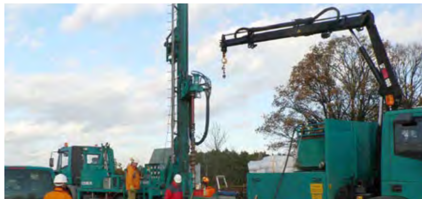
Rammkernsondierungen zur Bodenuntersuchung an einer CO 2 -Messstelle.
