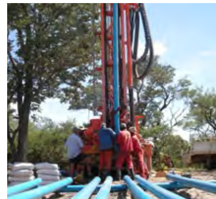
Bohrarbeiten im Cuvelai-Etosha-Becken zur Erkundung des Grundwasserleiters.
