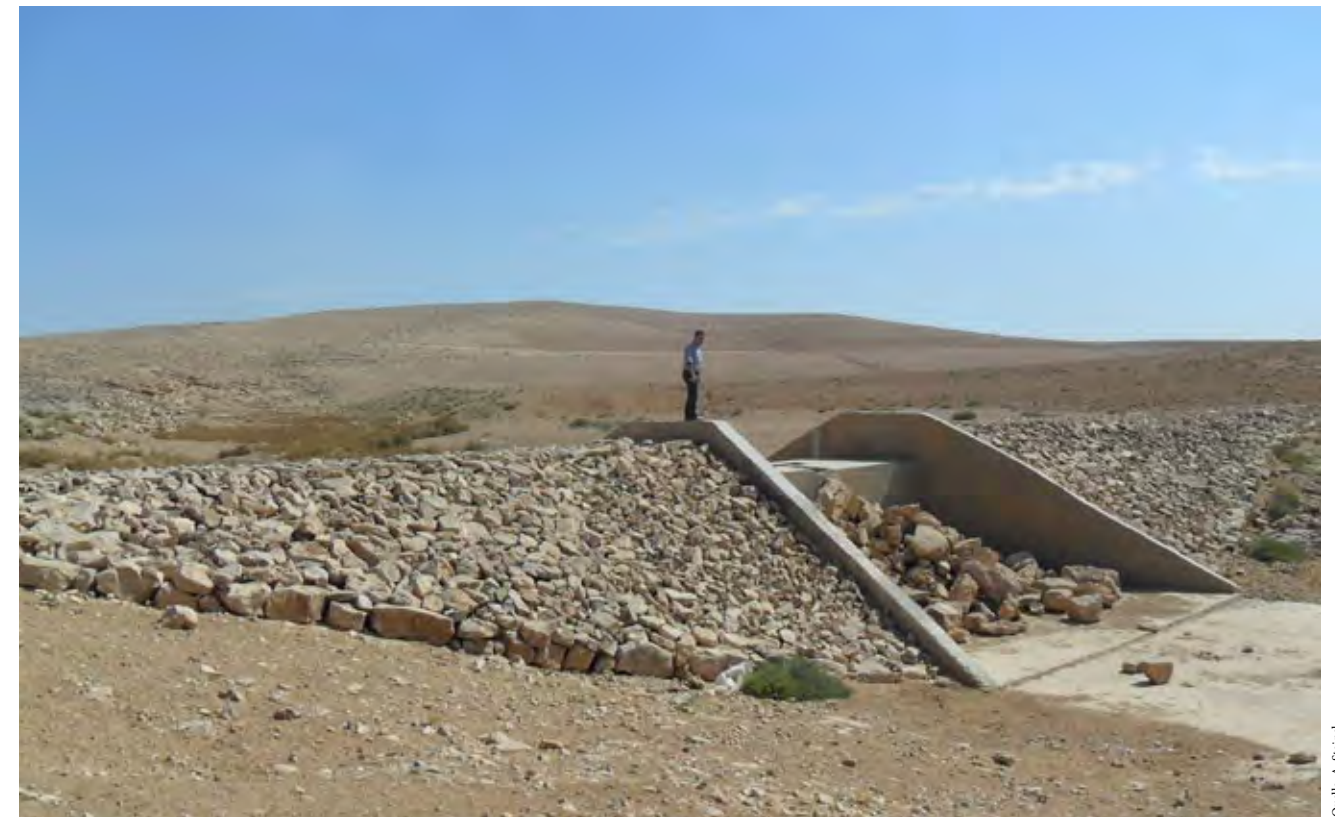
Beispiel für einen kleinen Infiltrationsdamm im Wadi Madoneh, Jordanien.
