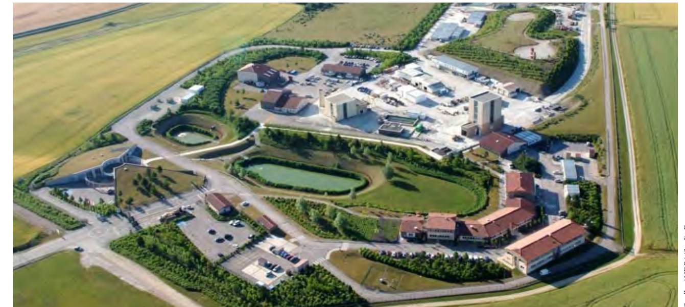
Luftaufnahme der übertägigen Anlage des Untertagelabors Meuse/Haute-Marne (Frankreich).
