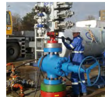
Umbau des Bohrlochkopfes zum Freispülen der Bohrung.
