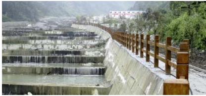
▲ Sicherheitsvorkehrung in China zum Schutz vor Muren nach dem Wenchuan Erdbeben in 2008.
