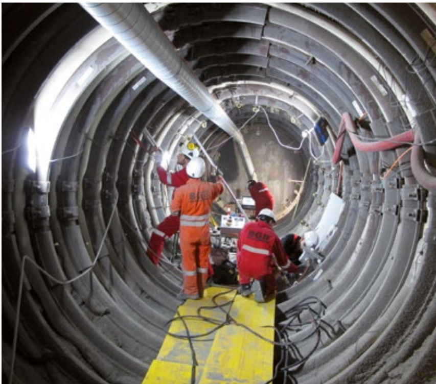
▲ BGR-Mitarbeiter bei geowissenschaftlichen Messungen im Einlagerungstunnel im schweizerischen Felslabor Mont Terri.
