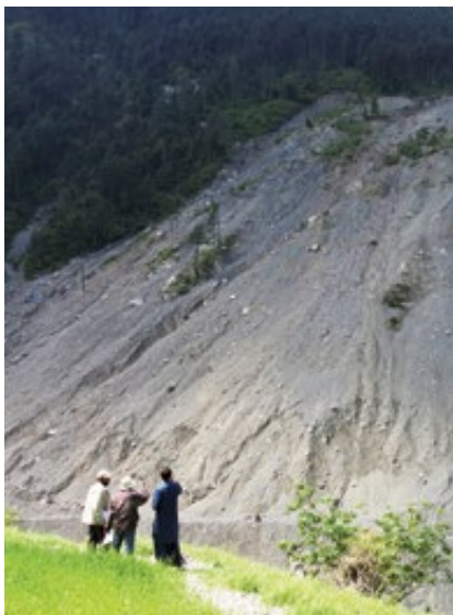
▲ Unterbrechung der N15 Straße östlich von Paras, Distrikt Mansehra, in Pakistan durch eine Hangrutschung.
