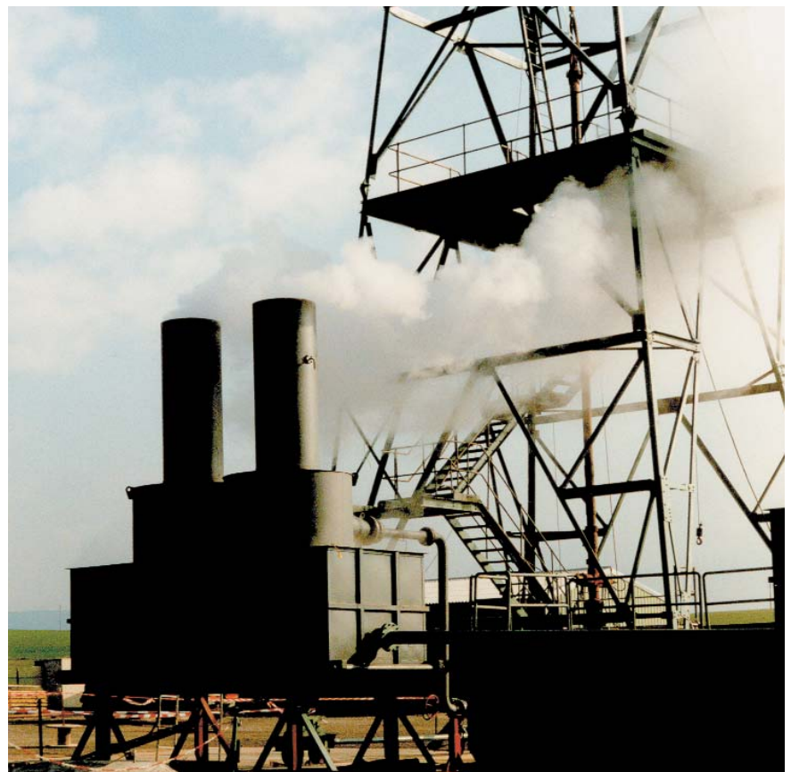
Die Geothermie-Anlage Soulitz bei einem Zirkulationstest.
