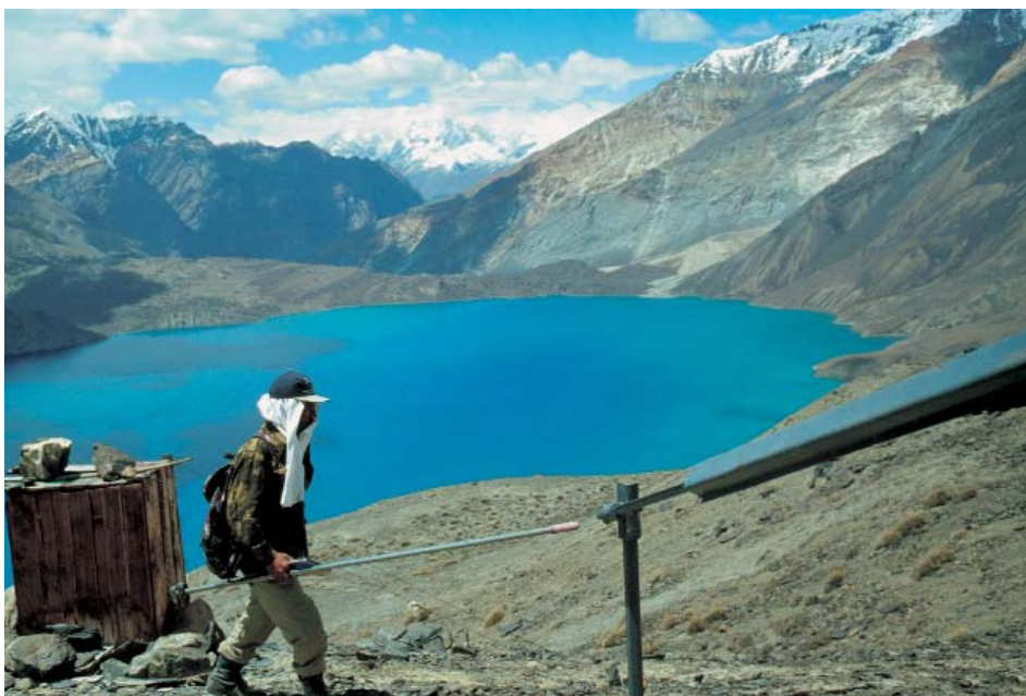
Der Sarez-See von der nördlichen Bergflanke aus, Blick stromab mit natürlichem Damm und Ausbruchsnische rechts. Im Vordergrund Extensometer-Messgeräte zur Überwachung der Hangbewegungen.
