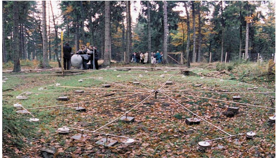
Rauschunterdrückungsfilter für Infraschallsignale, der als sternförmiges Rohrsystem ausgebildet und dem Infraschallsensor vorgeschaltet ist, nach Fertigstellung des Arrayelements.
