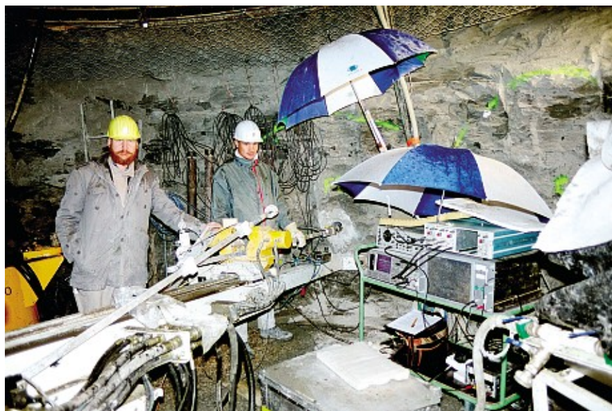
Versuchsaufbau unter engen Verhältnissen im Schachttiefsten. Das Bohrloch mit Sonde ist in der Bildmitte zu sehen. Geringe Mengen Spritzwasser von oben machen eine „Abschirmung“ der Apparatur erforderlich.
