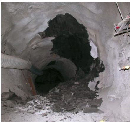
Gemessene Permeabilitätsverteilung um die Strecken (links) und aufgenommene Einbrüche während Auffahrungsphase (rechts).
