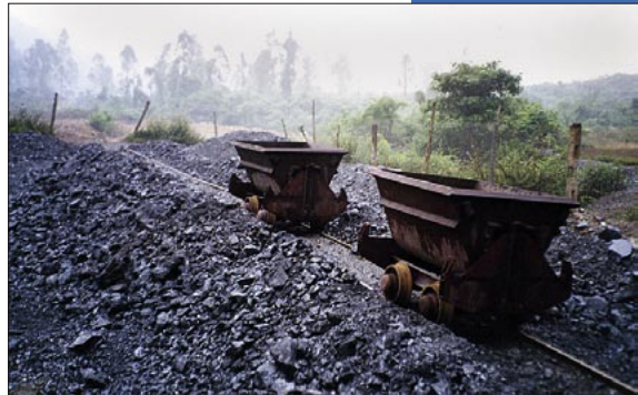
Arbeitssicherheitsrisiko: Nicht eingezäunte, öffentlich zugängliche Eisenerzhalde. Die von Hand bewegten Loren sind nicht gegen unkontrolliertes Wegrollen gesichert.
