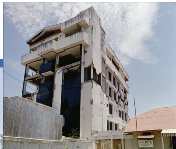
Banda Aceh: durch Erdbeben am 26. 12. 2004 zerstörtes Behördengebäude (August 2005).
