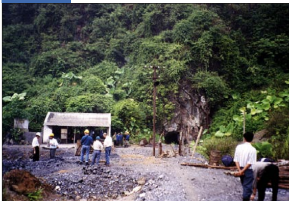
Unfallträchtig: Ein ungesicherter, öffentlich zugänglicher Stolleneingang zu einem untertägigen, aktiven Eisenerzabbau.
