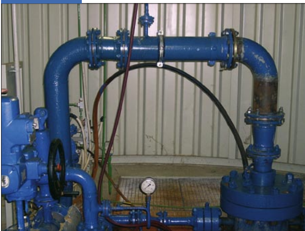
Sondenkopfinstallationen der Förderbohrung in Neustadt-Glewe.
