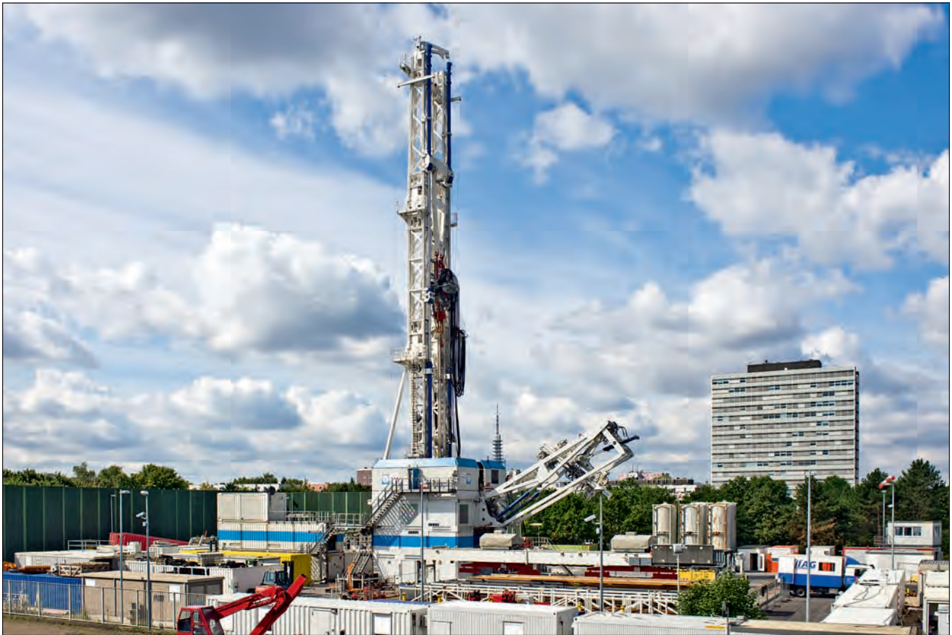
Bohrplatz während der Bohrarbeiten im Jahr 2009 mit der InnovaRig-Bohranlage im Zentrum.
