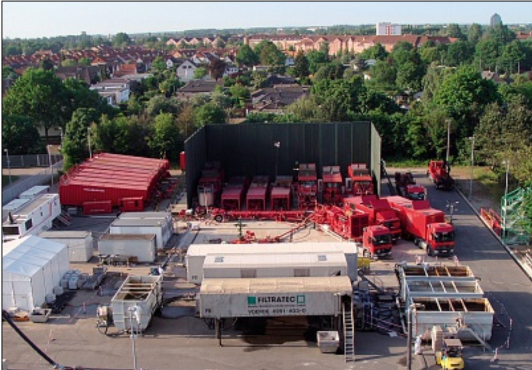
Übersicht über den Bohrplatz während der Fracoperation im Mai 2011.
