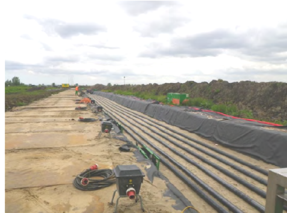
Baustelle TenneT (NL), 1 System, Quelle nkt cables
