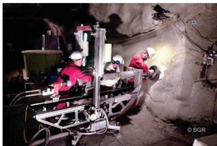
Gebirgsspannungs-Messungen mit der BGR-Überbohrsonde
