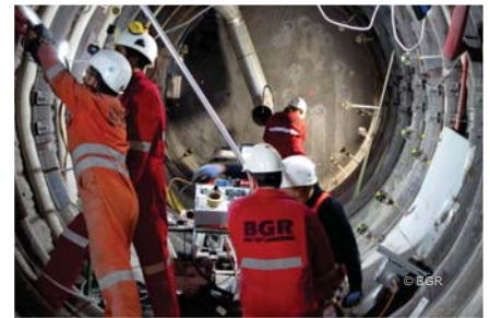
Geophysikalische In-situ-Messung, ausgehend von einer Tunnelwand
