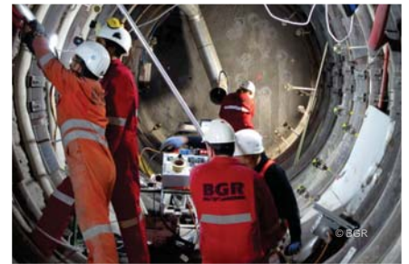
Geophysikalische In-situ-Messung, ausgehend von einer Tunnelwand
