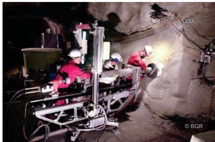
Gebirgsspannungs-Messungen mit der BGR-Überbohrsonde
