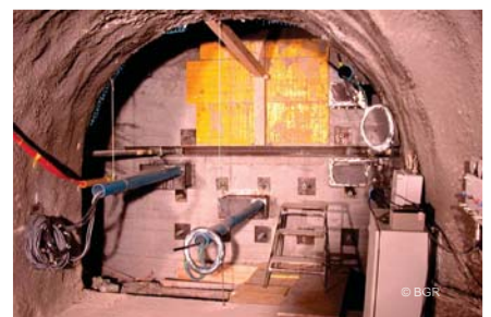
Dieselbe Nische wie links wurde nach der Verfüllung 10 Jahre dauerüberwacht
