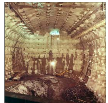
Maschinenkaverne während der Auffahrung, Sicherung mit Felsankern & Spritzbeton (PSW Waldeck II)
