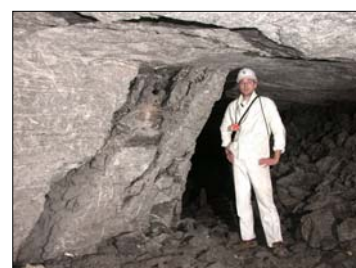
Anstehender Fels im Verbrauchsbereich der Untertageanlage Neckarzimmern
