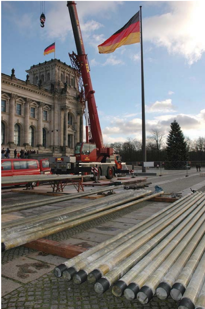
Abbildung 3.19: Pumpe Reichstag: Ziehen der Pumpe. Foto: BGR
