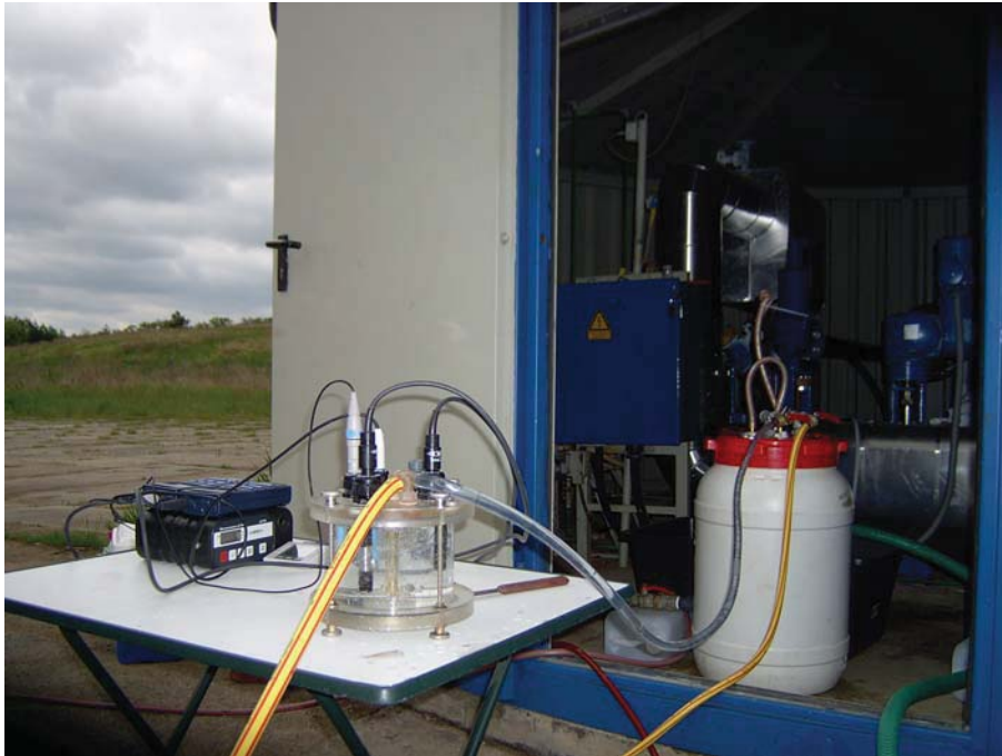
Abbildung 2.2: Kühlung des zu beprobenden Fluides über einen Wärmetauscher am Fördersondenkopf der Bohrung in Neustadt-Glewe
