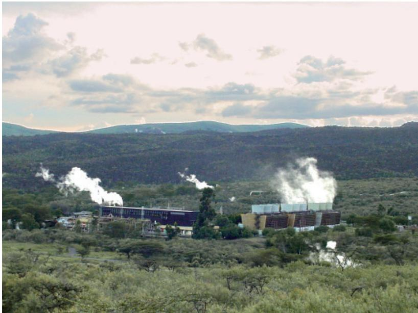
**Abbildung 7.9:** Das Geothermiekraftwerk Olkaria I in Kenia begann im Jahr 1981 mit der Erzeugung geothermischen Stroms. Aktuell sind  $45 \text{ MWe}$  installiert; die durchschnittliche Verfügbarkeit liegt bei über 98%.
