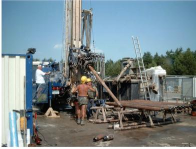
**Abb. 1.3a:** Bohren der Pumpenkammer, Lufthebeverfahren
