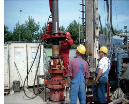
**Abb. 1.3c:** Rohreinbau und Bohrlochkopfmontage
