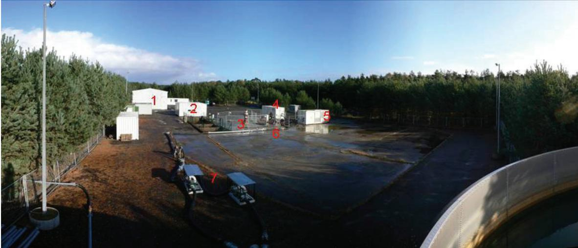
**Abb. 1.8:** Bohrplatz der Bohrung Horstberg Z 1: (1) Lager- und Montagehalle; (2) Messcontainer; (3) Pumpenkammer; (4 u. 5) Hochdruckpumpen; (6) Bohrlochkopf; (7) Niederdruckleitungen mit Ladepumpen
