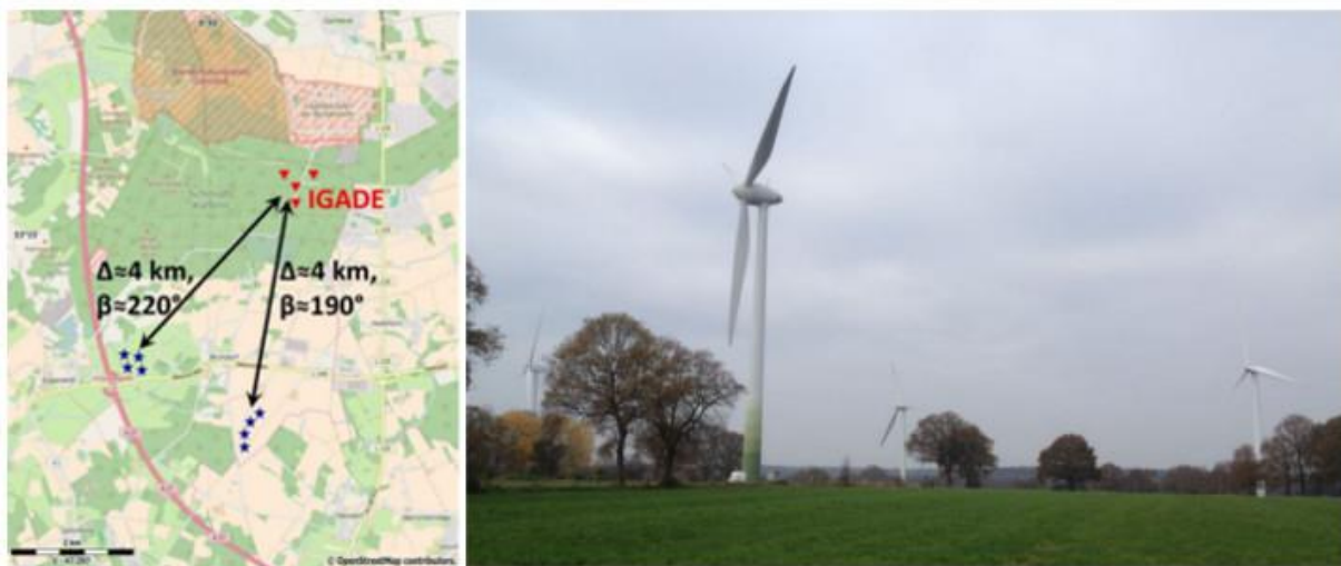
Abbildung 2: Windenergieanlagen (hier: vier Enercon 1800 kW südwestlich von IGADE, in Betrieb seit 2005) in 4 km Umkreis zum Infrasschall-Array IGADE nördlich von Bremen. Vier weitere Anlagen in südlicher Richtung wurden 2006 errichtet.
