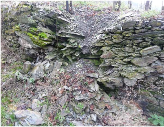
Abbildung 117: Impressionen aus dem Gelände: verkippte und zerbrochene Weinbergsmauern weisen auf eine aktive Rutschung hin (Fotos: C. Wolf, Februar 2014).
