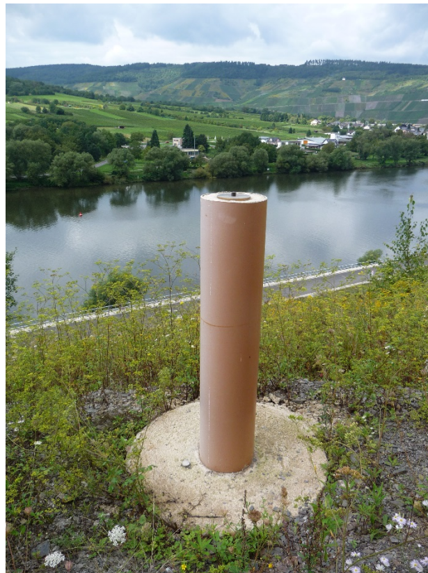
Abbildung 158: Foto des Messpfieilers RB 1 (Foto: C. Wolf, September 2014).
