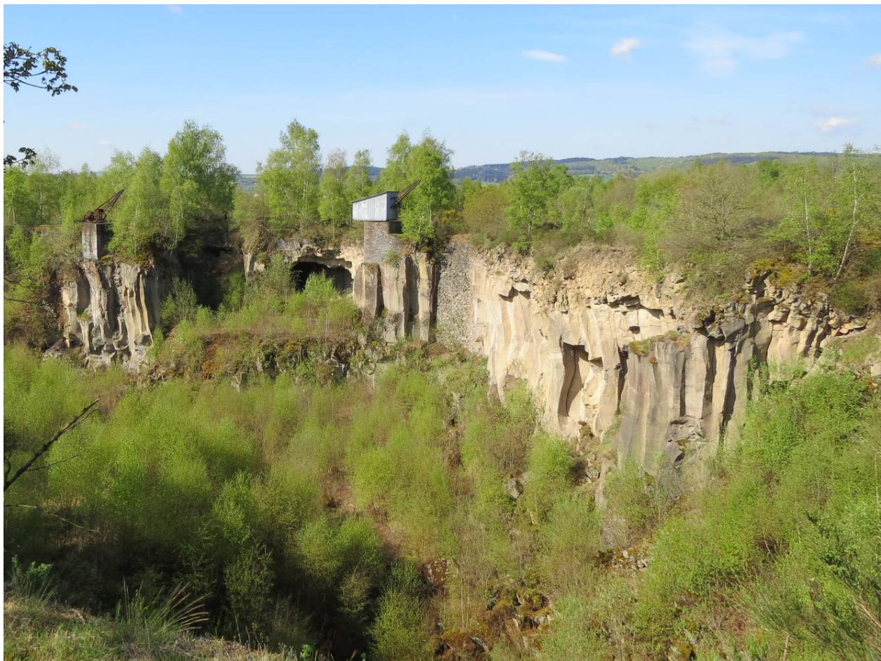
Abbildung 35: Mayener Grubenfeld mit Grubenkränen auf gemauerten Kransockeln und Anschnitt eines gemauerten Schachtes. Schmalen Säulen (Siegel) und dicke Säulen (Schienen) des Mayener Lavastroms. (Foto: C. Wolf, April 2015).
