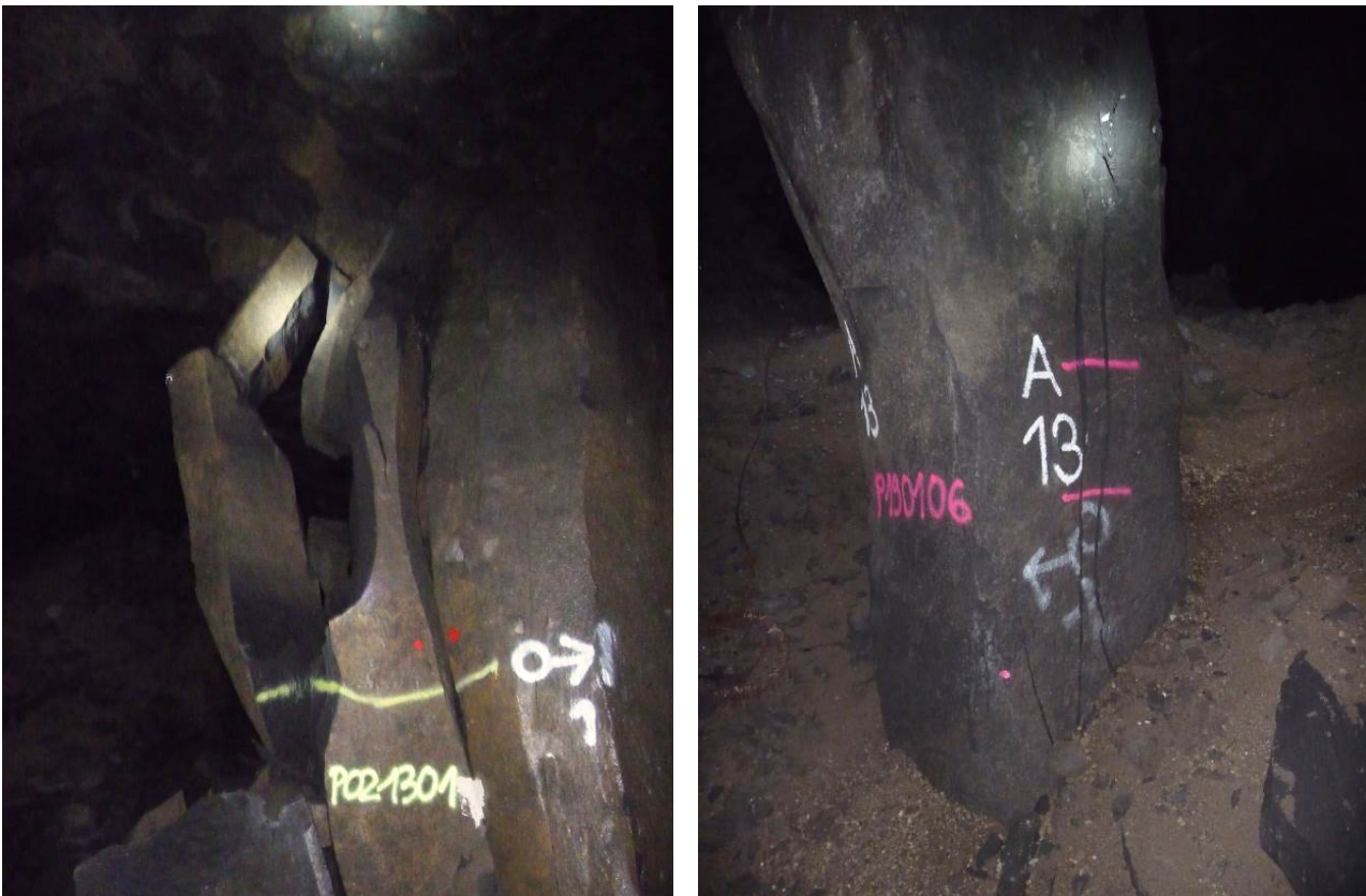
Abbildung 31: Schwer beschädigte Basaltpfiler mit Messmarkierungen (Foto: C. Wolf, Februar 2014).
