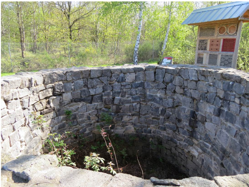
Abbildung 92: Ungefähre Position von Bewegungsgebiet 7 im Bereich eines gemauerten Schachtes (Foto: C. Wolf, April 2015).
