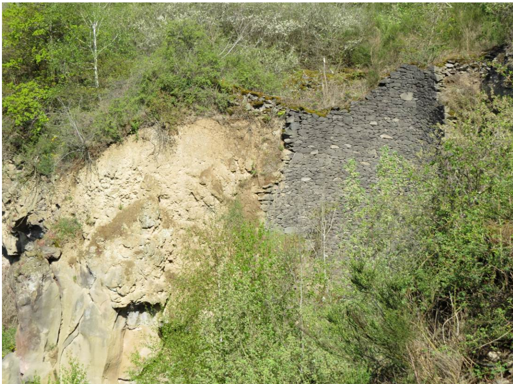
Abbildung 90: Ungefähre Position von Bewegungsgebiet 5 im Gelände am Rand des Tagesbaus. Im linken Bereich befindet sich ein vom Tagebau angeschnittener gemauerter ehemaliger Schacht (Foto: C. Wolf, April 2015).
