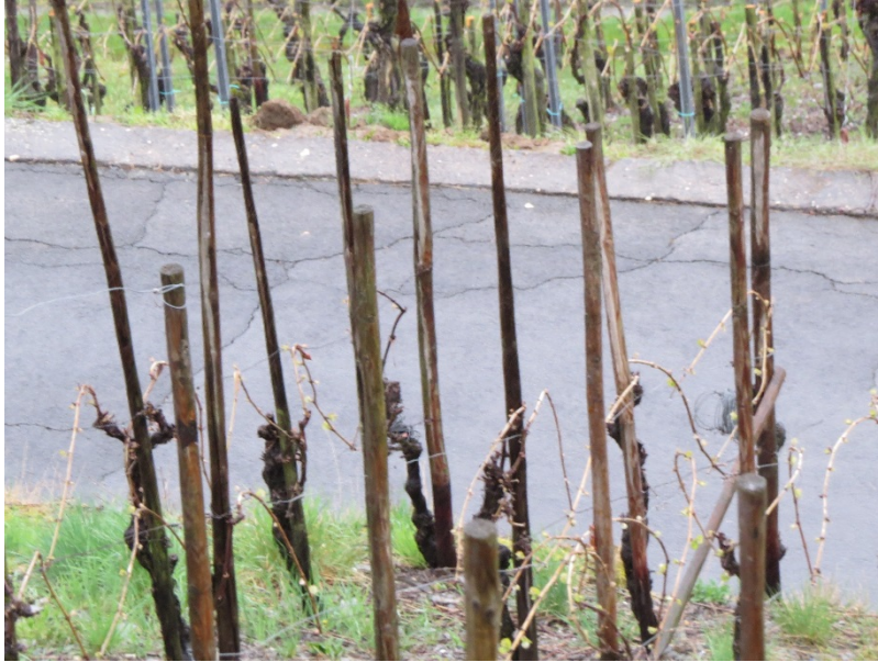
Abbildung 19: Straßenschäden im Weinberg (Foto: C. Wolf, April 2015).
