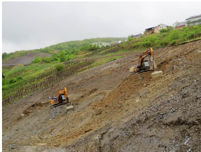
Abbildung 120: Rutschungssanierung (Foto: C. Wolf, September 2014).
