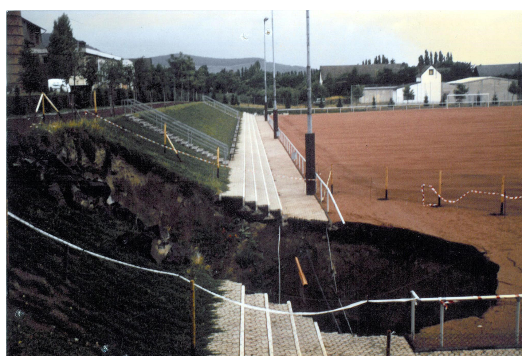
Abb. 8: Tagesbruch von 1988 am Sportplatz in Mendig (Foto: LGB).
