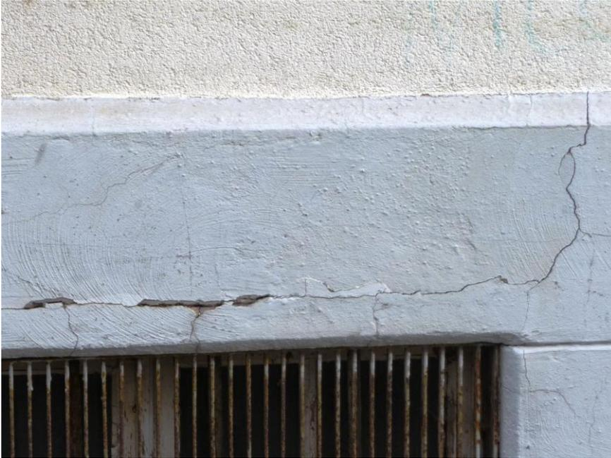
Abbildung 30: Risschäden an einem Gebäude im Gebiet des PanGeo Polygons.
