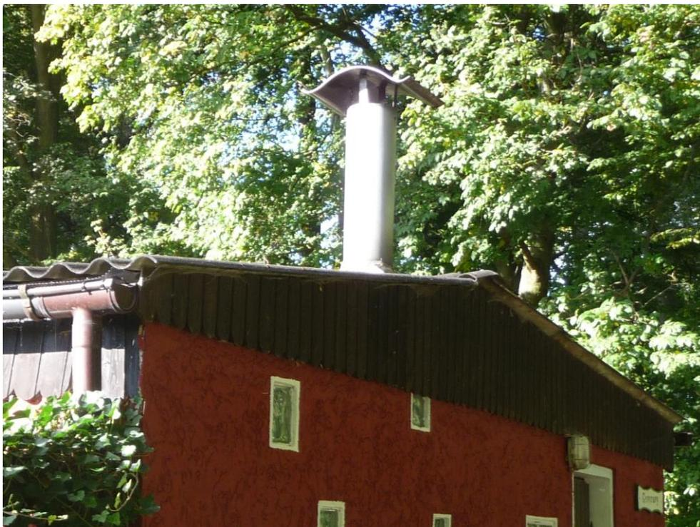
Abbildung 16: Schornsteinabdeckung, die häufig als stabiler Reflektor identifiziert wird.
