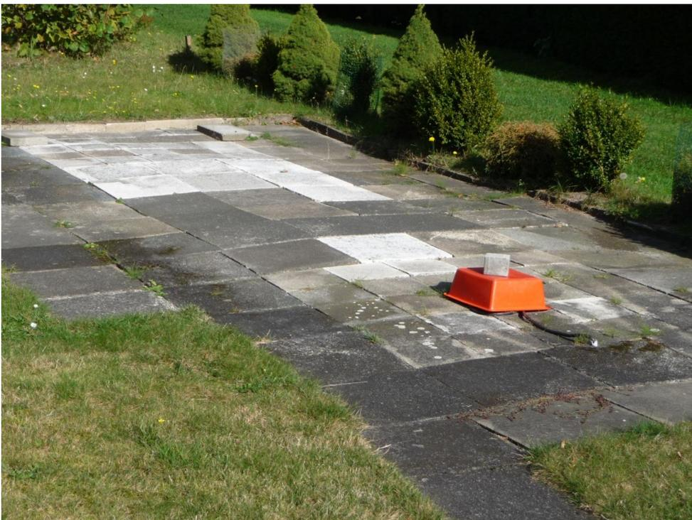
Abbildung 12: Geländefoto einer Wohnwagenstellfläche. Die Bodenbewegung ist an der Verschiebung der Steinplatten erkennbar.
