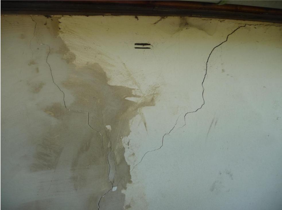
Abbildung 18: Risschäden an einer Laube.
