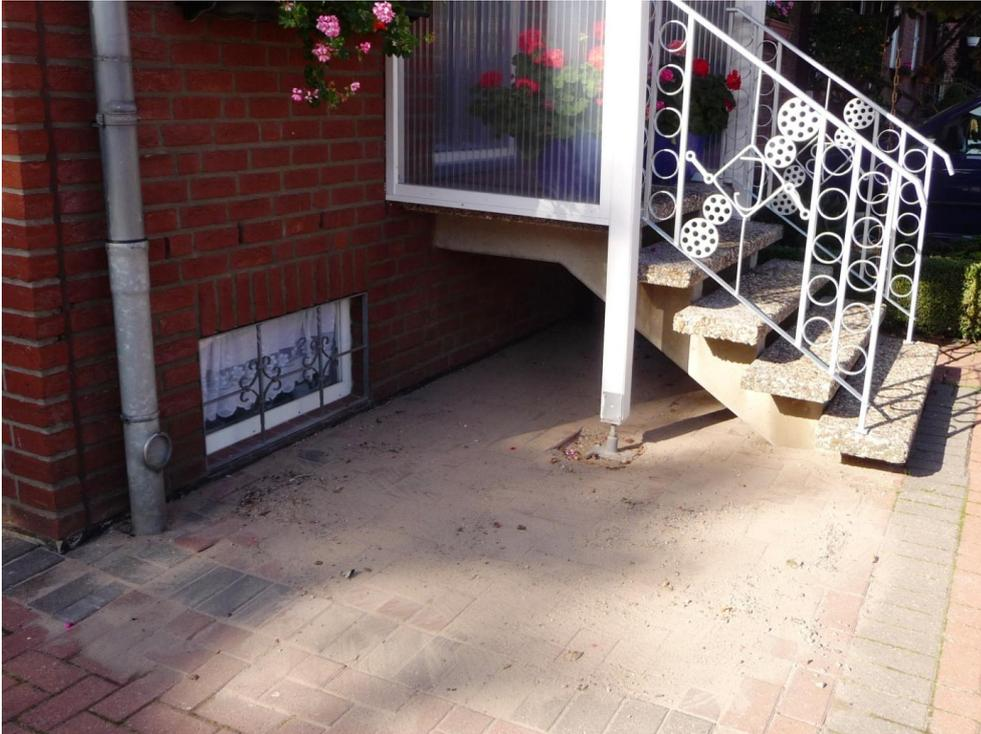
Abbildung 35: Durch die ungleichmäßige Setzung des Vorbaus senkte sich diese Treppe auf der rechten Seite stärker ab.
