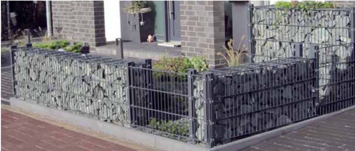
Mit gebrochenen Natursteinen gefüllte Gabionen als Grundstücksbegrenzung, Foto: BGR.
