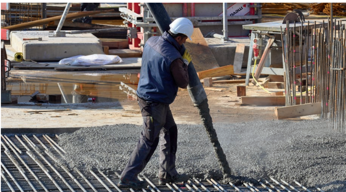
Betonieren einer Bodenplatte mit Transportbeton, Foto & Copyright: Holger Kotzan, InformationsZentrum Beton GmbH.
