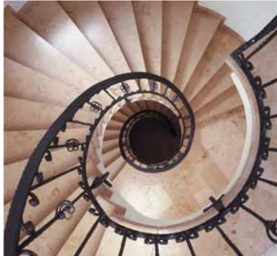
Wendeltreppe mit Stufen aus fränkischem Jura-Kalkstein, Foto: Deutscher Naturwerkstein-Verband e. V.
