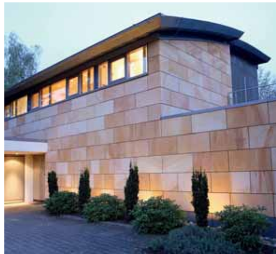
Haus bei Kaiserslautern mit Außenwandbekleidung aus pfälzischem Schweinstaler Sandstein, Foto: Deutscher Naturwerkstein-Verband e. V.
