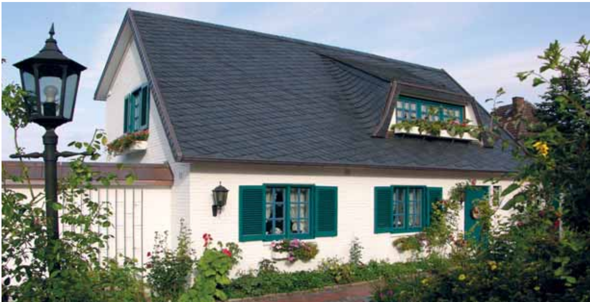
Einfamilienhaus mit Dachdeckung aus Moselschiefer in Glücksburg, Schleswig-Holstein, Foto: Rathscheck Schiefer und Dach-Systeme.
