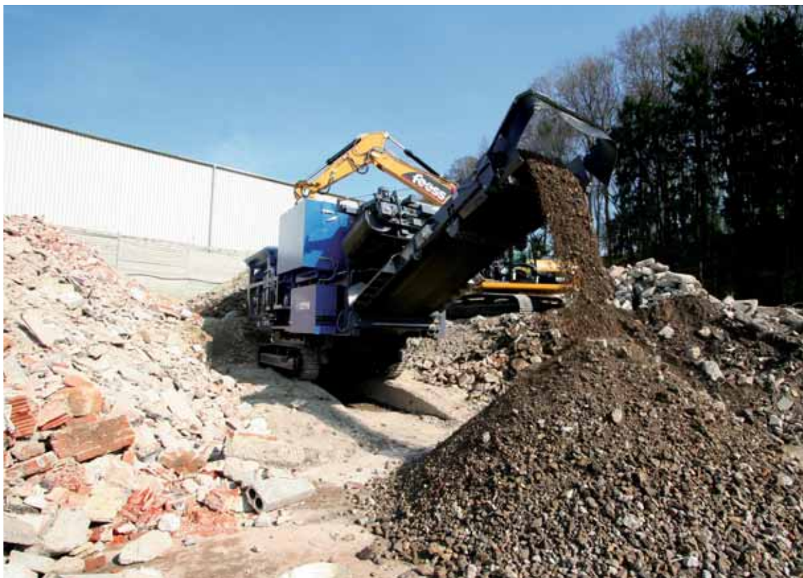
Die Verwertungsquote mineralischer Bauabfälle lag 2014 bei ca. 89,5 %, Foto: Industrieverband Steine und Erden Baden-Württemberg e. V. (ISTE).
