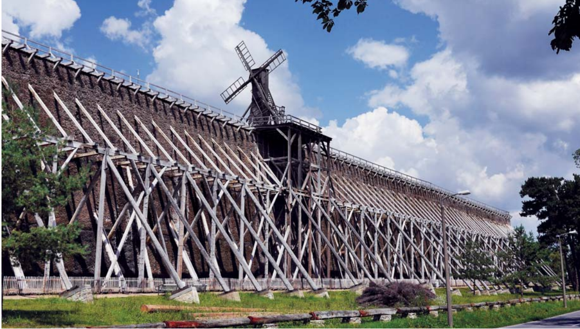
Das zwischen 1756 und 1765 erbaute Gradierwerk in Bad Salzelmen, Sachsen-Anhalt, war einst mit 1.837 m Länge das größte in Deutschland. Heute sind hiervon im Solepark von Bad Salzelmen noch rund 320 m erhalten, Foto: Frank Bothe / Wikipedia.
