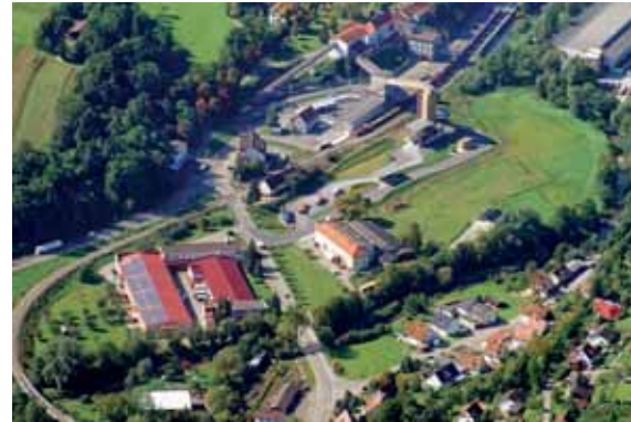
Luftaufnahme des Bergwerks Stetten im Zollernalbkreis. Hier spielt sich fast alles untertägig ab und nur das Salzsilo und die Verladeanlagen zeigen, dass hier Rohstoffe gewonnen werden, Foto: Wacker Chemie AG (mit frdl. Genehmigung).
