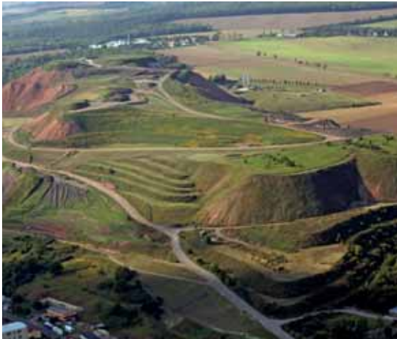
Nach 20 Jahren erfolgreicher Sanierung ist die Kalihalde Sondershausen zwar nicht verschwunden, aber fügt sich durch ihre Begrünung harmonischer in das Landschaftsbild ein und belastet deutlich weniger die Umwelt, Foto: Glückauf Sondershausen Entwicklungs- und Sicherungsgesellschaft mbH (mit frdl. Genehmigung).
