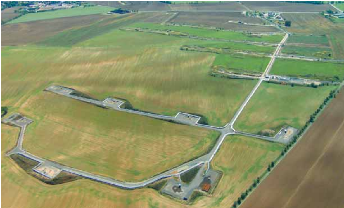
Blick über das Solfeld Kehmstedt im Frühling, Foto: DEUSA International GmbH (mit frdl. Genehmigung).
