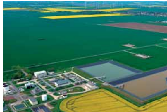
Blick auf das Sol- und Speicherfeld Teutschenthal, Foto: H. Fechner, The Dow Chemical Company (mit frdl. Genehmigung).
