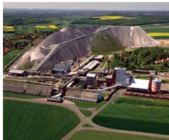
Das Kaliwerk Sigmundshall westlich Hannover mit markanter Rückstandshalde, die teilweise schon begrünt ist, Foto: K+S AG (mit frdl. Genehmigung).
