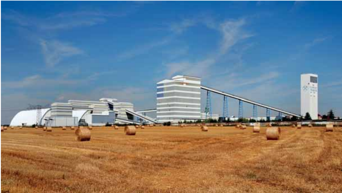
Blick auf die übertägigen Anlagen des Bergwerks Bernburg, Foto: K+S AG (mit frdl. Genehmigung).
