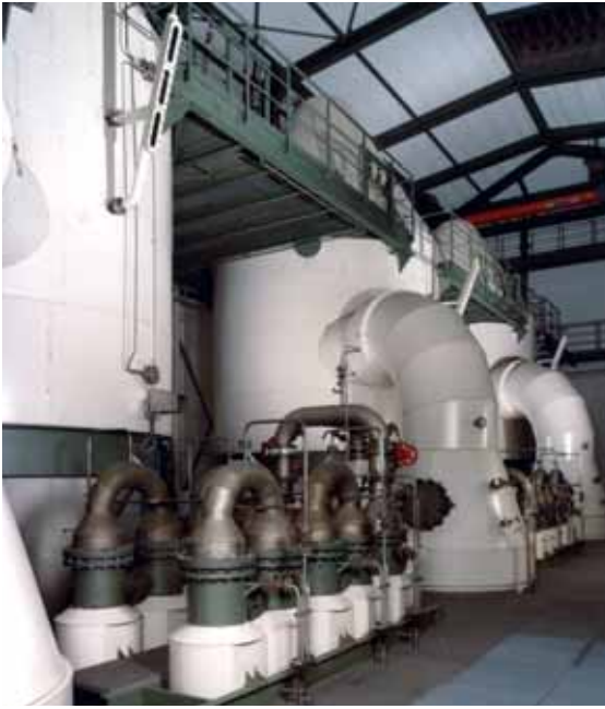
In der Neuen Saline in Bad Reichenhall wird Siedesalz durch Thermokompression gewonnen, Foto: Südwestdeutsche Salzwerke AG (mit frdl. Genehmigung).
