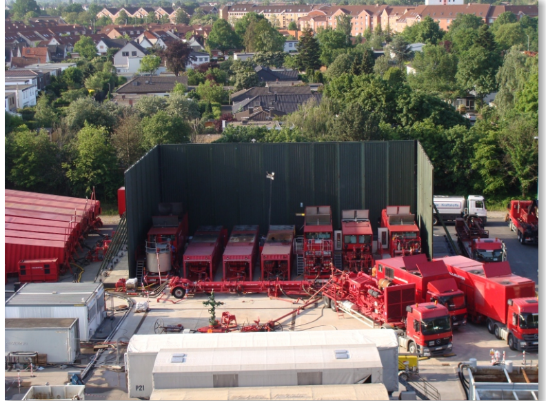
Bohrplatz Groß Buchholz G11 während der Frac-Operation im Mai 2011. Links die Wassertanks (rot), in der Mitte der Bohrkopf (grün), dahinter (durch die Lärmschutzwand abgeschirmt) die Hochleistungspumpen (rot), rechts die Steuerungseinheit, vorne die Wasseraufbereitungsanlage (weiß).
