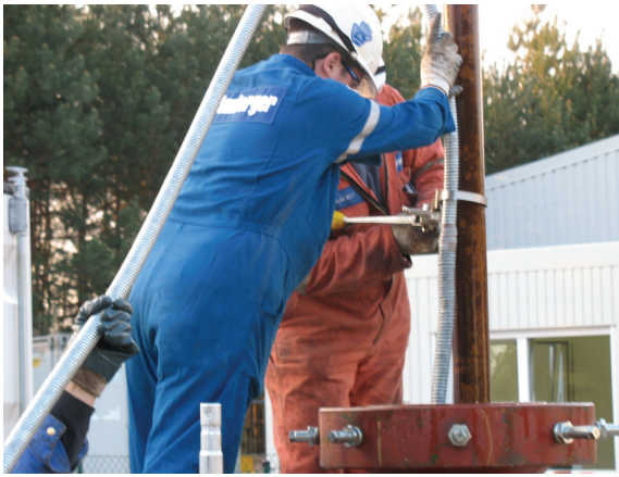
Abb. 1.4: Unterwasserpumpe der Fa. Schlumberger (Reda) und Einbau der Pumpe in die speziell errichtete Pumpenkammer.
