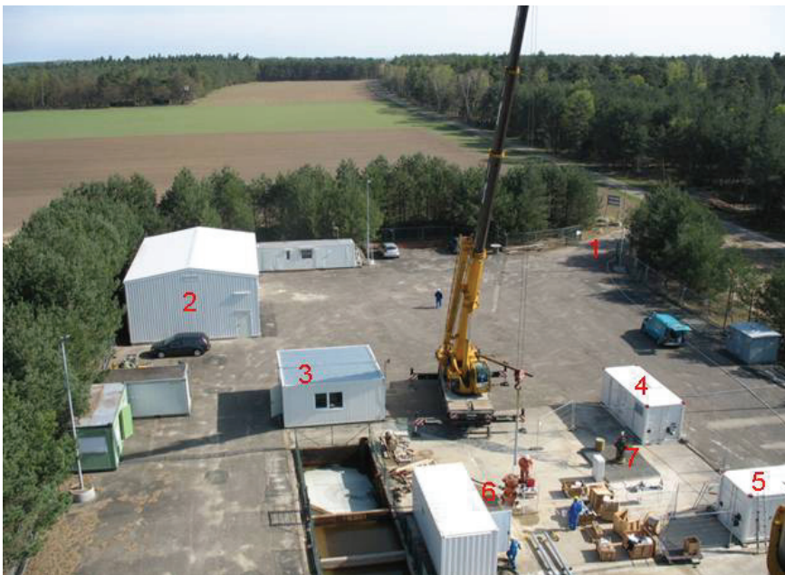
Abb. 1.9: Luftaufnahme Bohrplatz Horstberg Z1 während der Einbauarbeiten der Tiefpumpe. (1) Zufahrt (2) Lager- und Montagehalle (3) Messcontainer (4) u. (5) Hochdruckpumpen (6) Pumpenkammer und Steuerungscontainer (7) Bohrlochkopf
