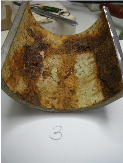
Abb. 4.2.17: Bereiche mit größeren Materialablösungen an der Innenwand einer Rohrprobe von unterhalb des Packers
