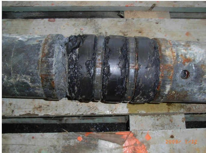
Abb. 3.8: Beschädigte Dichtelemente des alten Packers.
