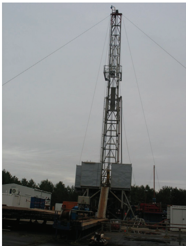
Abb. 3.2: Bohrlochwinde in Horstberg
