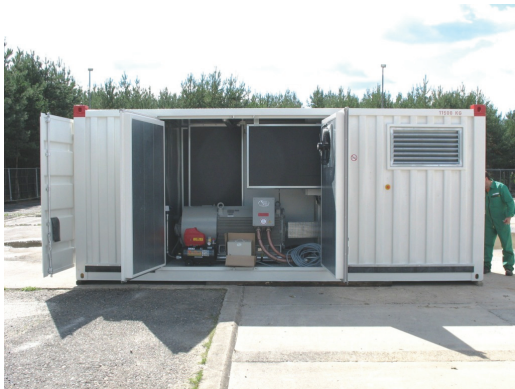
Abb. 1.5a: Hochdruckpumpe: Antriebsseite mit E-Motor
