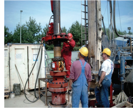
Abb. 1.3c: Rohreinbau und Bohrlochkopfmontage
