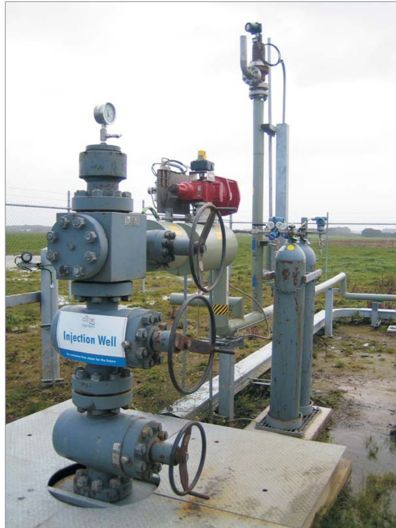
Bohrung zur CO 2 -Injektion in Australien
