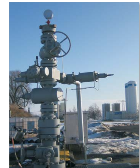
CO 2 -Injektionsbohrung mit Zwischenlager.
