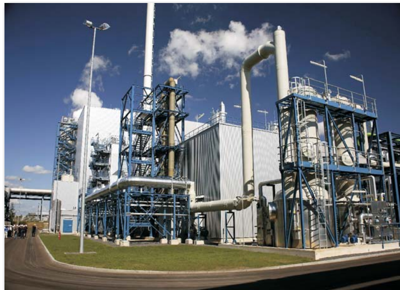
Oxyfuel-Pilotanlage Schwarze Pumpe. Bildrechte: Vattenfall
