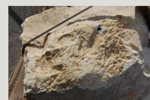
Piece of the basement Schlossplatz
