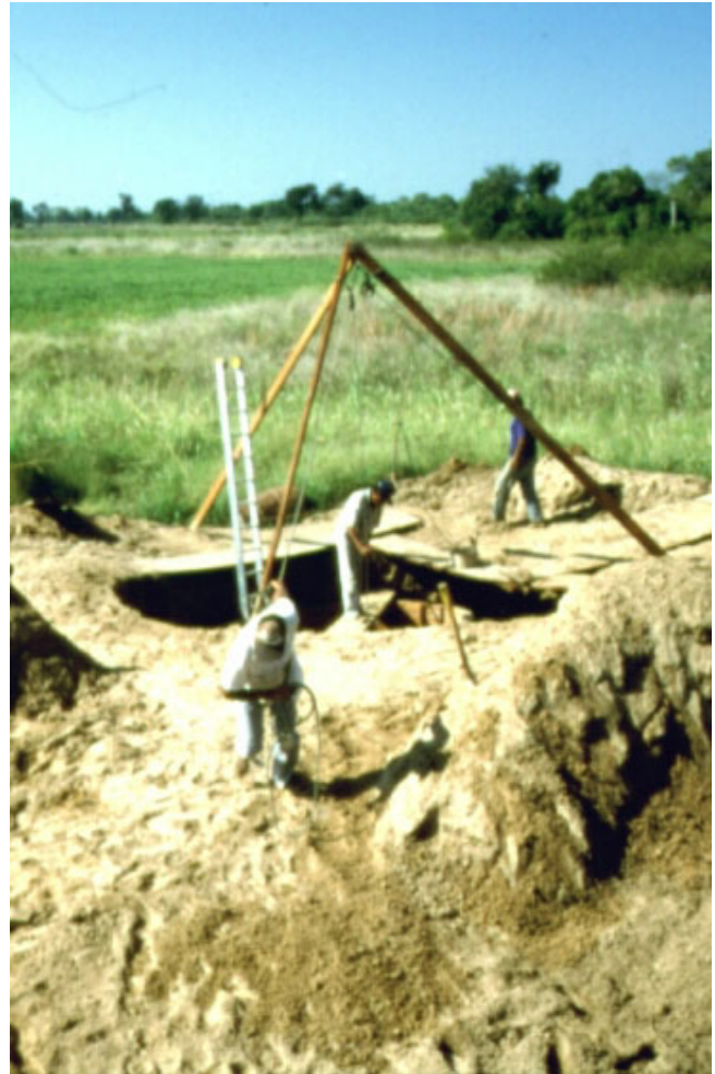
Abb. 5: Bau eines Brunnens. Ziegelmauerwerk, Innendurchmesser ca. 3m, Tiefe bis zu 15m. Foto: M. Junker
