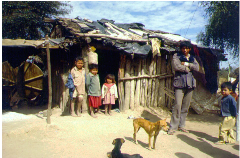
Abb. 2: Typische Wohnhütte der indianer im Chaco mit einer Abdeckung aus Plastikplane und Holzschindeln. Foto: M. Junker.
