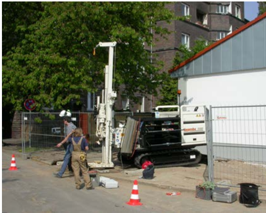
Abb. 9.60.: Die eingesetzte Sondiereinheit vom Typ 7730DT der Fa. Geoprobe (Sondierstelle Nr. 13 – Pilotystr.).
