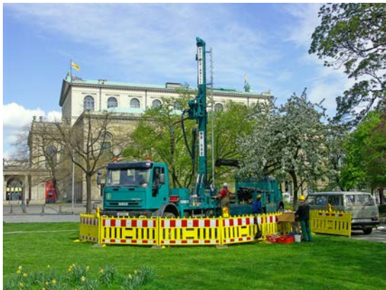
Abb. 9.4.: Gesamtansicht der Bohranlage (Georgsplatz, GWM 180968–70) Vordergrund: Bohranlage. Hintergrund: Hilfsfahrzeug.
