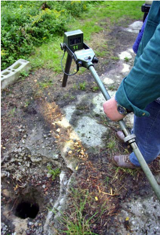
Abb. 9.2.: Tiefensonde zur Kampfmitteldetektion Lokation: Lutherstraße 32a (180928)
