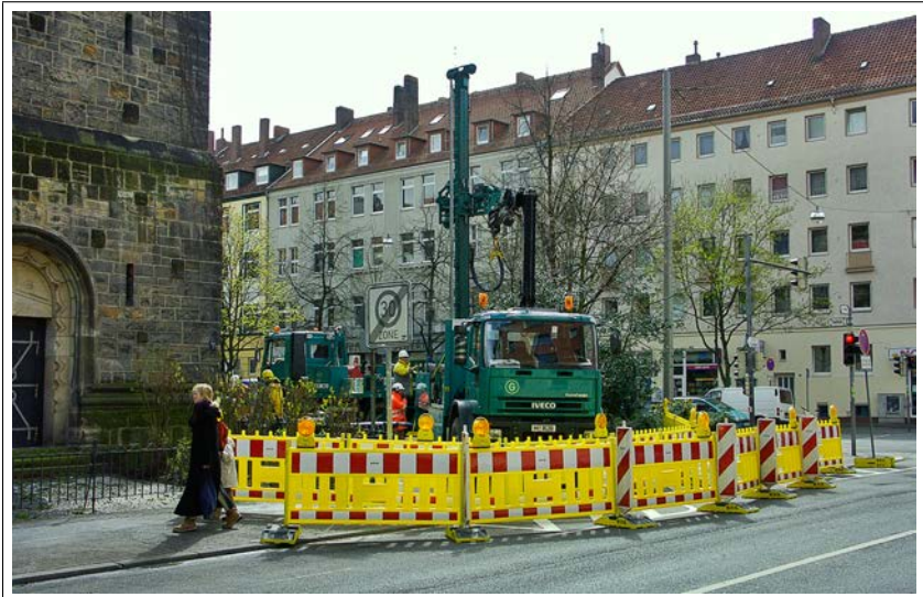
Abb. 9.3.: Baustelleneinrichtung des Ansatzpunktes 180959 (Sallstr. 55, Nazarethkirche). Halteverbotsbeschilderung und Umleitung des Fußweges
