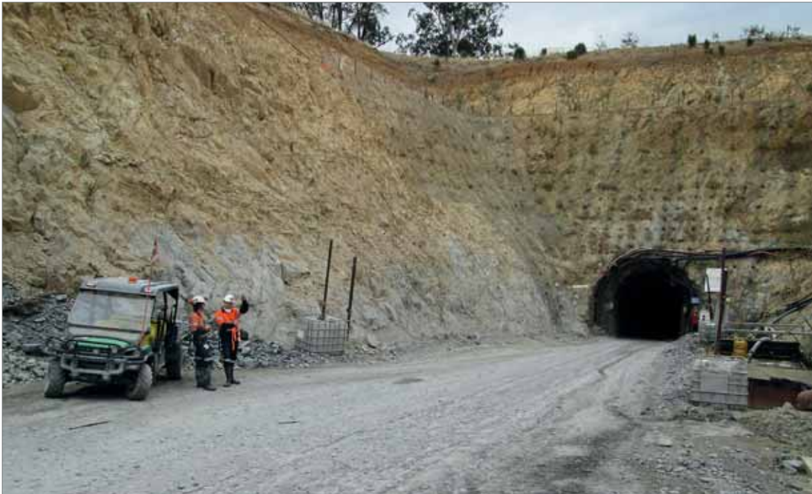
Abb. 2.1.2: Zugang zum Bergwerk Costerfield des Unternehmens Mandalay Resources Inc. im Bundesstaat Victoria (Foto: BGR, Wiedergabe mit freundlicher Genehmigung von Mandalay Resources Inc.).
