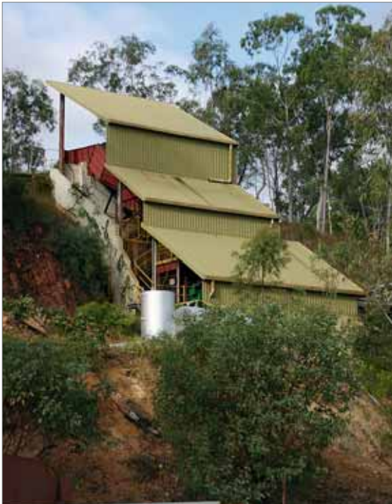
Abb. 2.27.4: Blick auf die Mt. Veteran Aufbereitungsanlage, Queensland (Foto: BGR).
