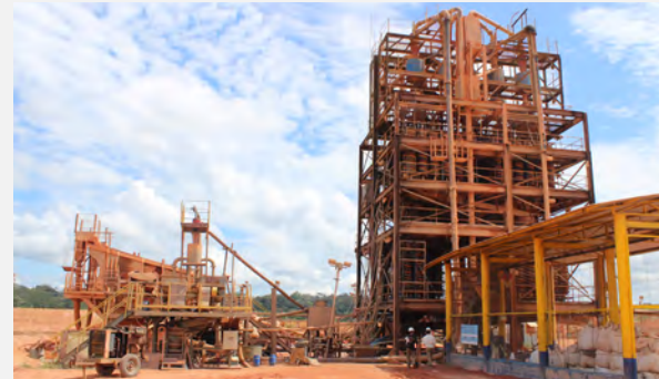
Ore processing plant with spiral separators in the Estanho de Rondônia SA Santa Bárbara tin mine (ERSA).
