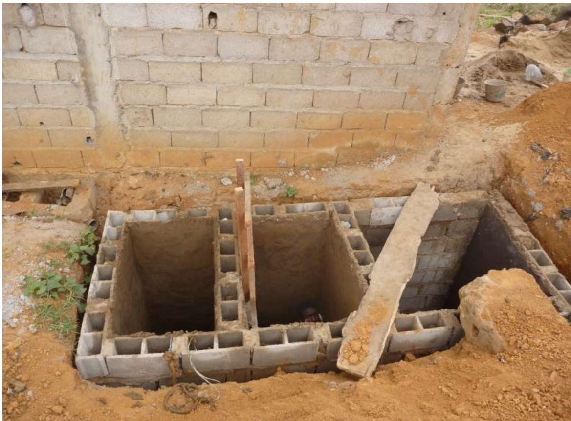
Figure 56: Construction d'une petite fosse septique à trois compartiments sur une pente qui va de Messa-Carrière à Tsinga-Olinga - Construction of a small three chambered septic tank on the slope below Messa-Carrière towards Tsinga-Olinga.
