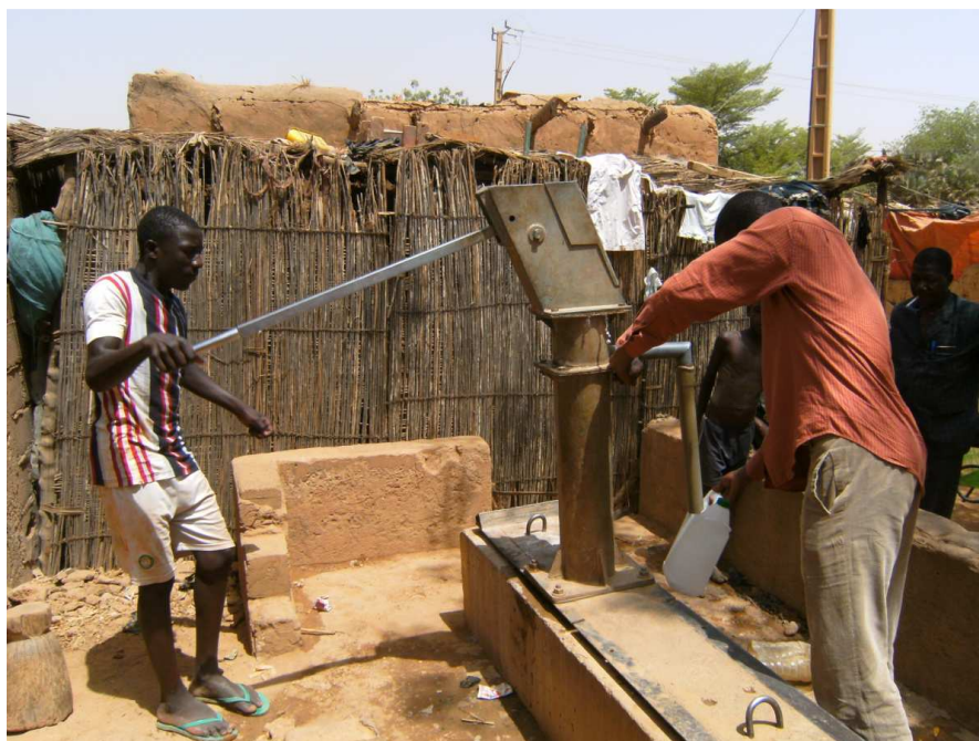
Figure 11 : Prélèvement d'eau souterraine d'un forage équipé (N°33) avec une pompe de motricité humaine « India » (Quartier Kouara Mé) (Photo : BGR)
