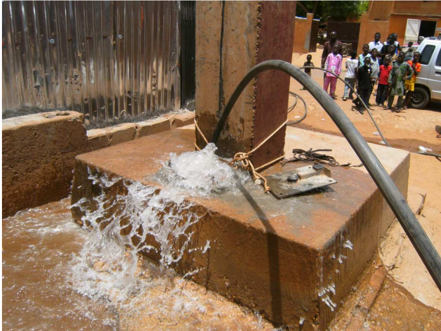
Figure 13 : Soufflage d'un forage abandonné (N°25, quartier Route Filingué / Église Garbado)
